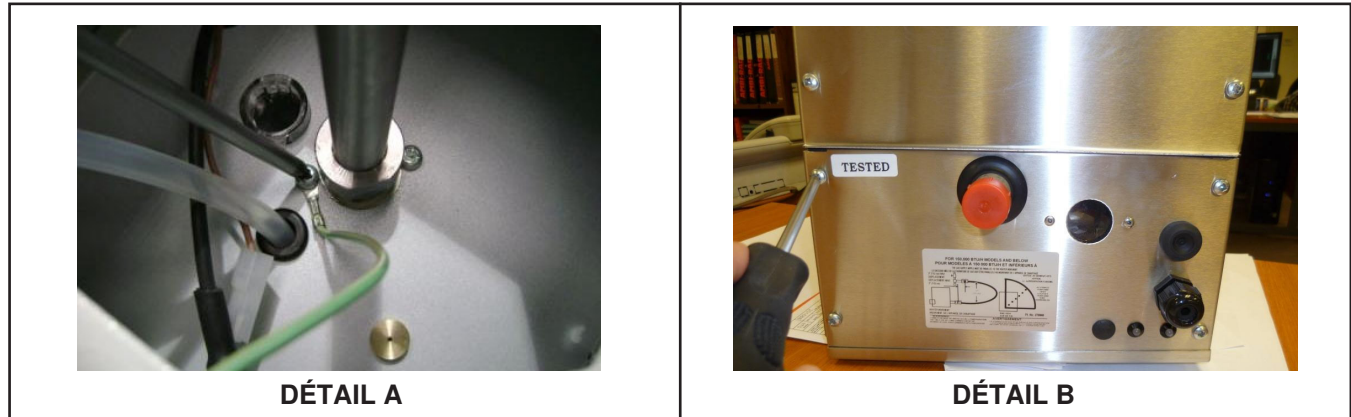
Figure 27. Retrait de la vanne de gaz combinée—modèles VCS, VCT et VPT
