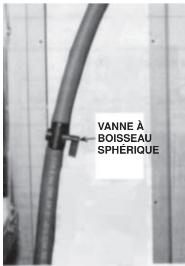
Figure 14. Vanne à boisseau sphérique
